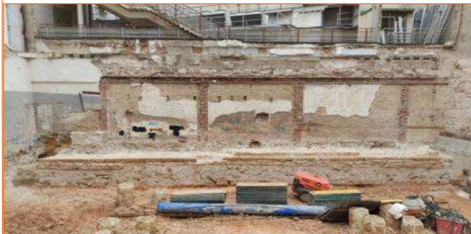
Foto 12. Vista general del MR 1 (UE 4, UE 5 i UE 6).
