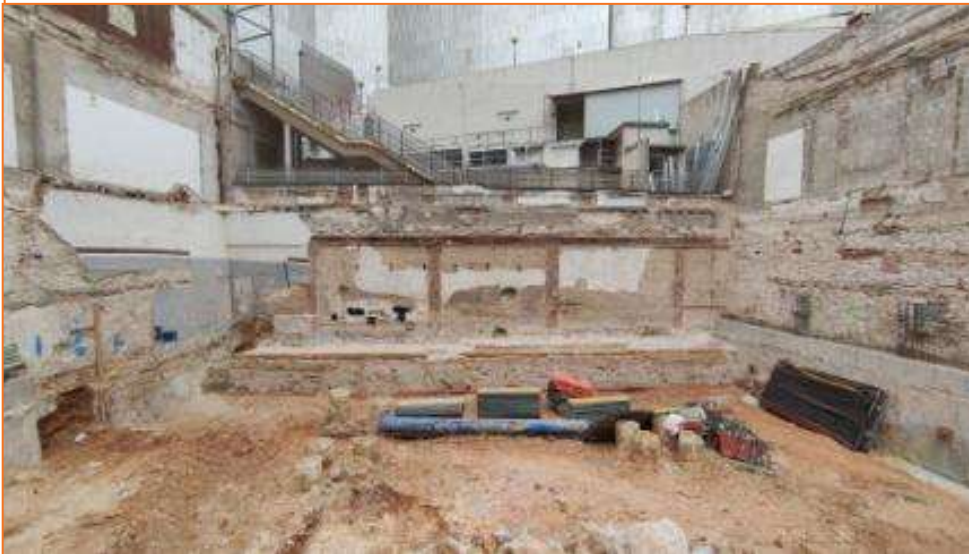
Foto 13. Vista general del MR 1 (UE 4, UE 5 i UE 6).
